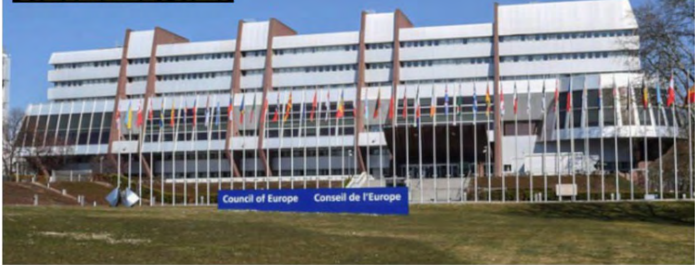
Das Gebäude des Europarats in Straßburg (Archivbild)
